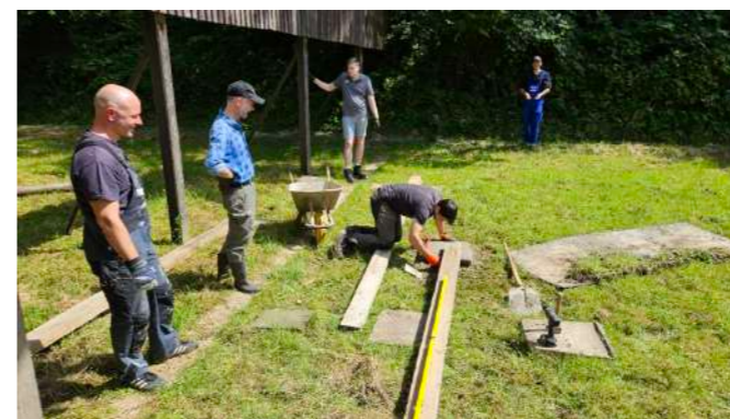
Umbau des 25 Meter Standes
